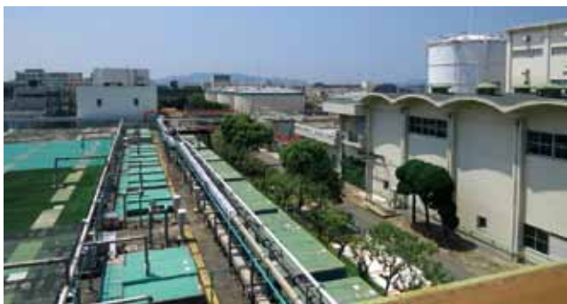
写真① 福岡市中部水処理センター
