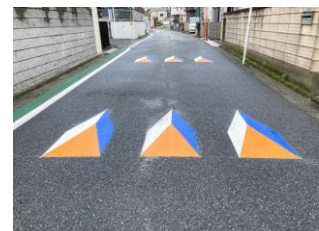
イメージハンプ：視覚効果によって立体的なコブのように見せて、車の減速を促す
